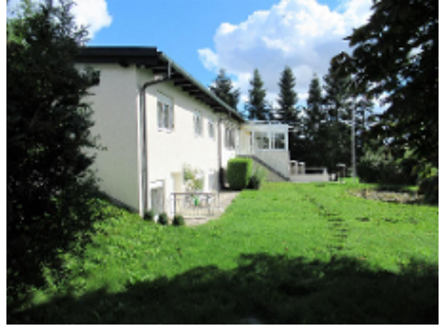
Außenansich Süd Altbestand
